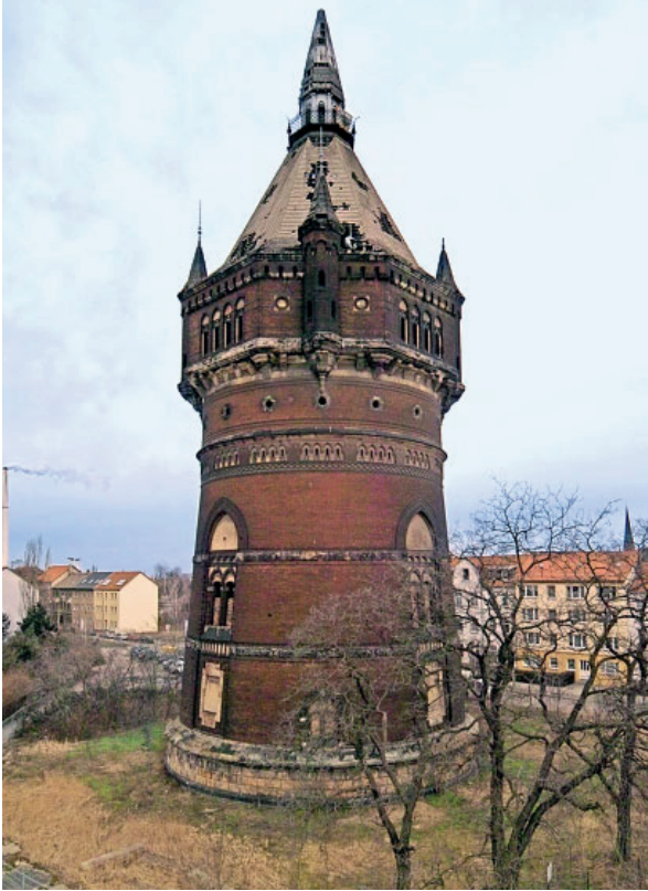
Der Neue Wasserturm vor der Dachsanierung (2007).
