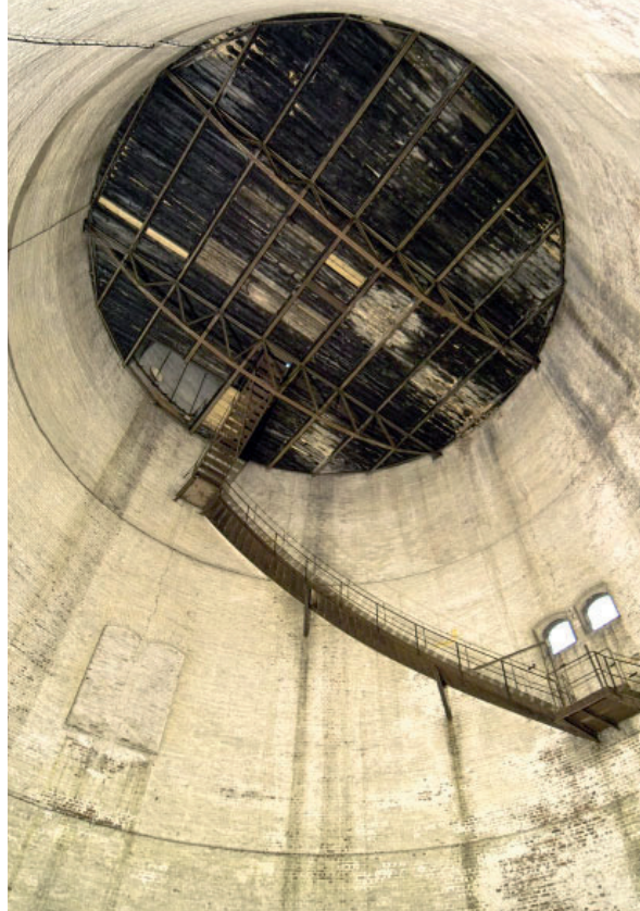
Blick in den Innenraum des Neuen Wasserturms.
