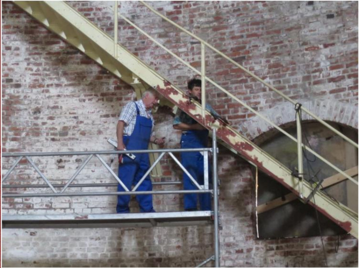
3. August – Fa. Bense bei der Treppensanierung
